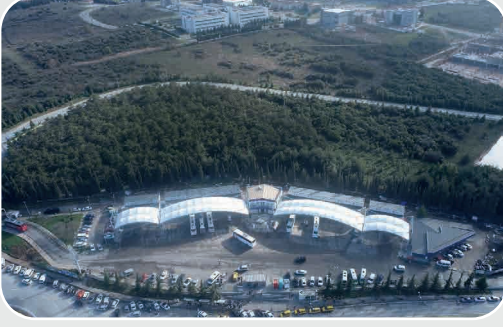
Gebze Şehirlerarası Terminal Tadilatı ve İlave İnşaat
