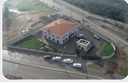
Gebze Adem Yavuz Mahallesi Emniyet Merkezi
